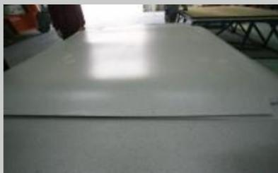
Пол в помещении: ковер из ПВХ, огнестойкость класса В1 - трудновоспламеняемый, цементный фибролит толщиной 19 мм, плотность  $\geq 1,3$  г/см<sup>3</sup>.
